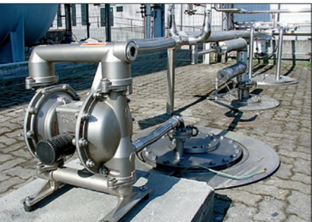
Bomba de diafragma de 1 1/2" instalada em um processo químico para transferir cloreto de metileno
