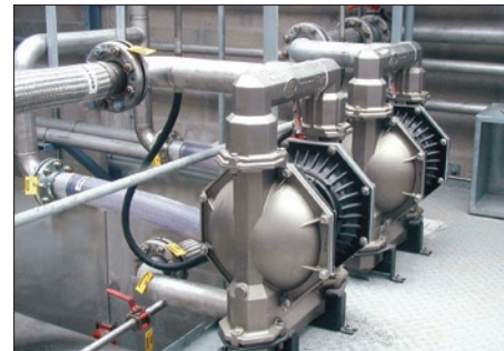
Bombas de diafragma de 3" instaladas em um processo de transferência a granel
