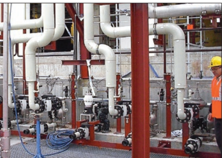
Bomba de diafragma de aço inox de 2" montadas com amortecedores de pulsação PVDF usadas para transferir ácido fluorídrico
